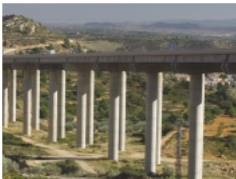
Viaducto de la carretera Madrid-Valencia (Buñol)
