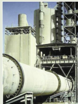
Figura 3.8. Horno y torre de ciclones
