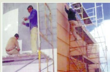
Figura 15. 3. Andamio sin condiciones de seguridad o empleado indebidamente.
