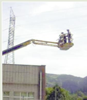
Figura 14. 4. Riesgo de electrocución por proximidad a cables de alta tensión
