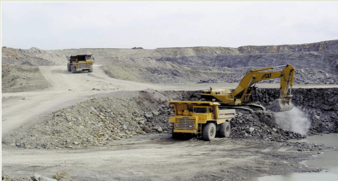
Figura 13. 3. Retroexcavadora cargando material en dúmper
