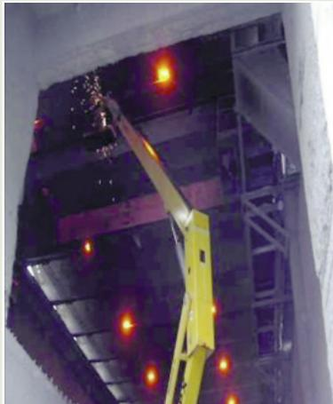
Figura 14. 8. Reparación puente grúa
