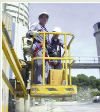
Figura 14. 5. Exceso de carga de la plataforma
