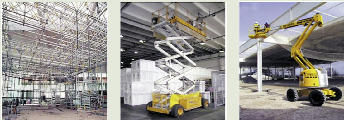
Figura 14. 1. Principales posibilidades para la realización de los trabajos en altura
