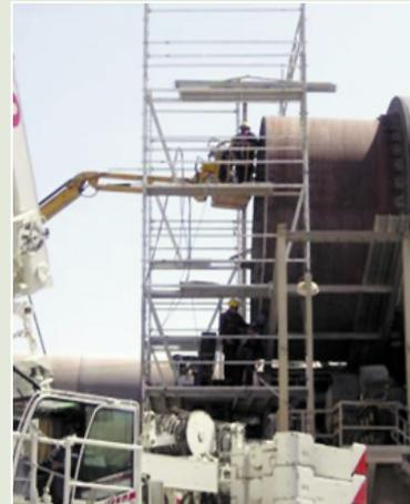
Figura 14. 9. Reparación horno
