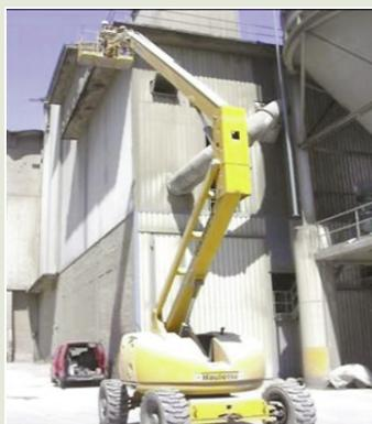
Figura 14. 3. Ausencia de señalización zona de trabajo
