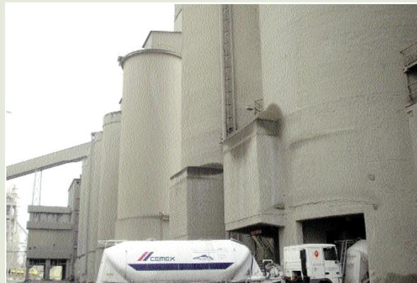
Con relativa frecuencia es necesario realizar un vaciado total de los silos y tolvas con el fin de eliminar pegaduras que material que se van acumulando sobre sus paredes, así como reparar los sistemas de fluidificación.
